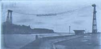
Construction du tablier par suspension de câbles / Bau der Brückenfahrbahn durch Aufhängung an Kabeln
