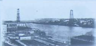
Construction des deux tours 1891 / Errichtung der zwei Türme 1891
