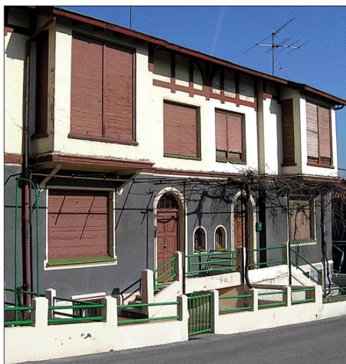
Fachada principal de las casas
